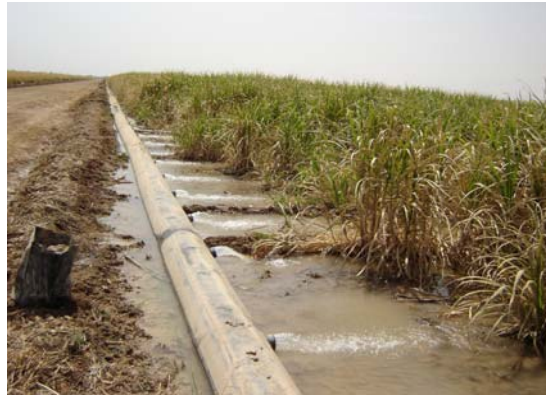
شکل ۱ - لوله هیدروفلوم در حالت آبیاری معمولی
