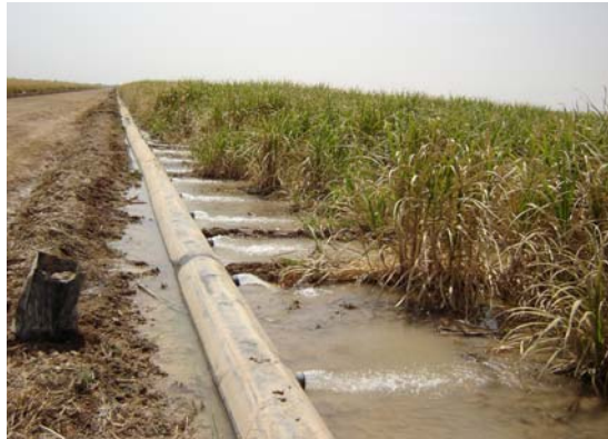
شکل ۱ - لوله هیدروفلوم در حالت آبیاری معمولی
