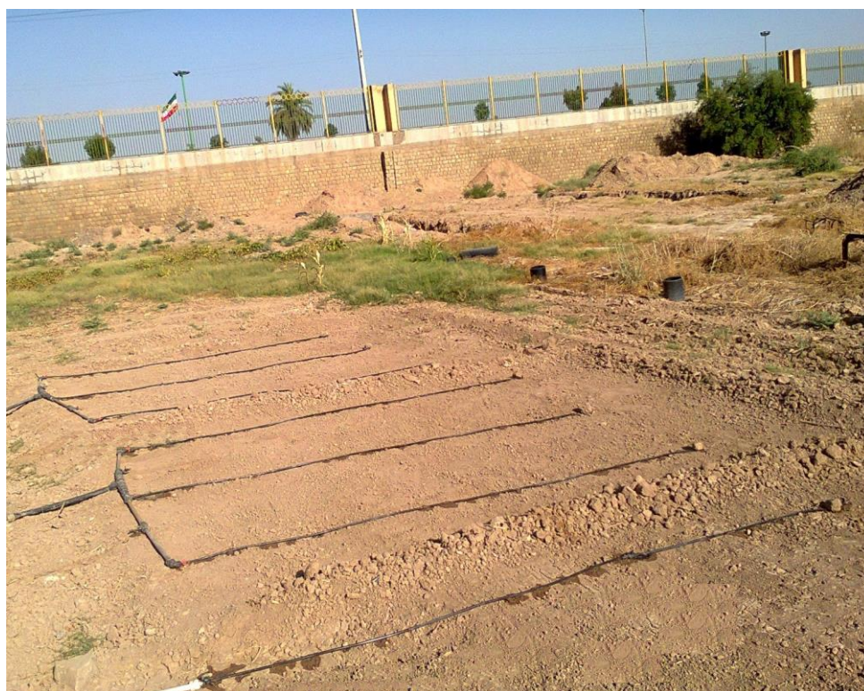
شکل ۲- آبیاری قطره‌ای- نواری در حال کار
